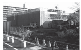
建設がすすむ福祉保健センター
